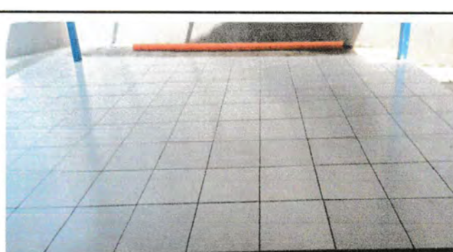
Foto 6: Sustitución de piso ceramico en corredor
