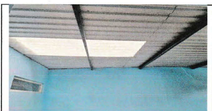
Foto 5: Estructura de techo y cubierta de laminas remozadas
