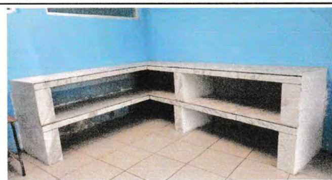
Foto 11: Reparación de azulejo en muebles de cocina
