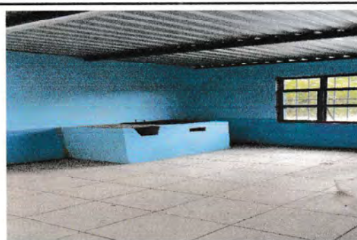
Foto 12: sustitución de piso ceramico en cocina
