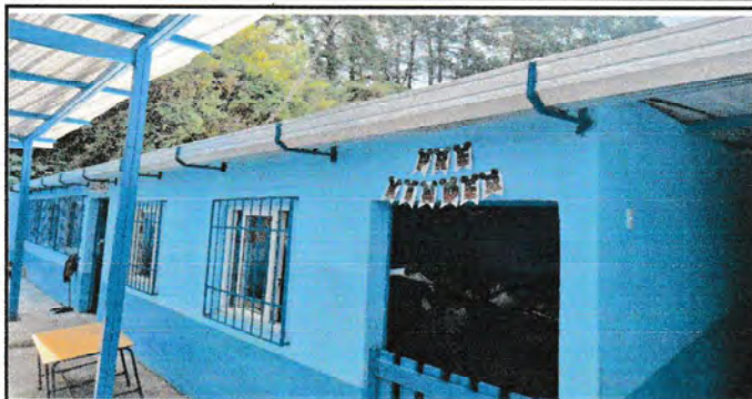
Foto1: Canales y bajadas de agua sustituidos
