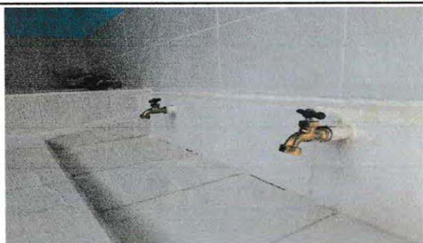
Foto 7: Chorro y Lavamanos remozados
