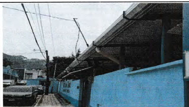
Foto 10: canales de agua pluvial instalados
